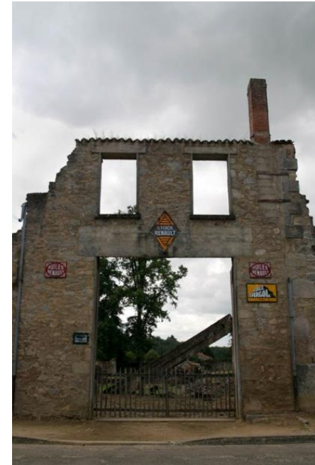
Garatge Poutaraud, identificat amb les plaques característiques.
